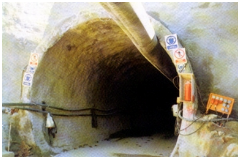
Zapadni portal tunela
