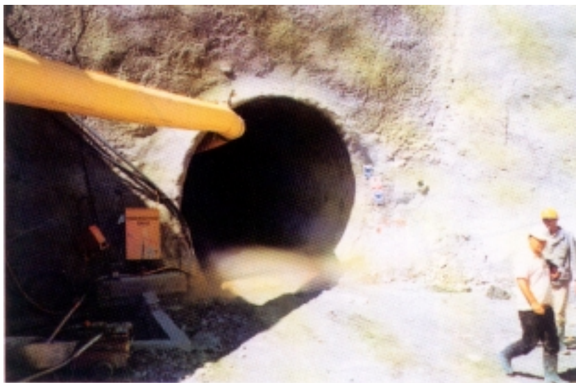
Istočni portal tunela nakon miniranja u tunelu
