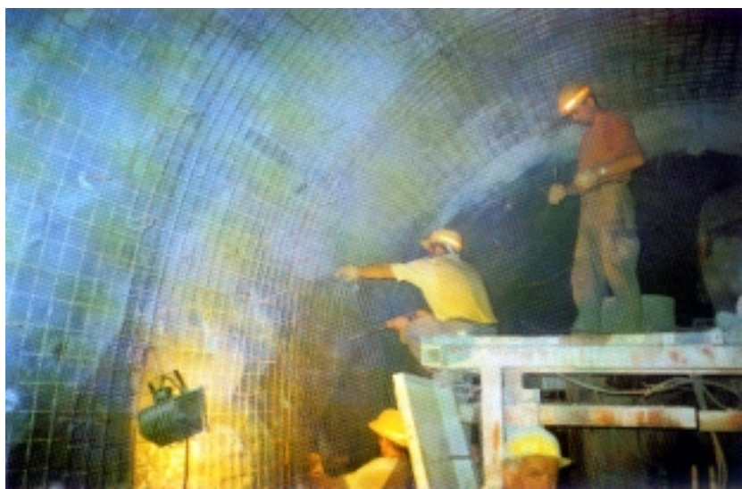
Postavljanje armature za podgradu
